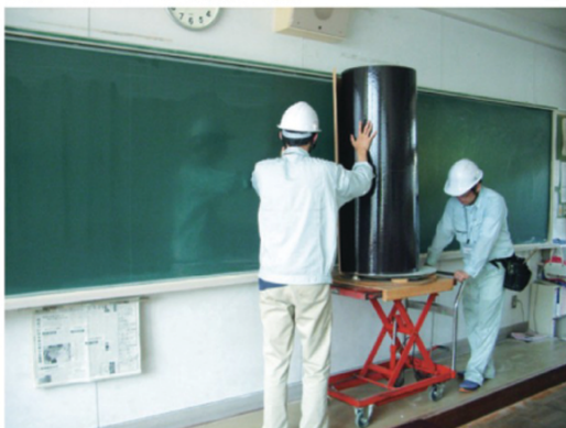
ピタマグロール貼替工法
